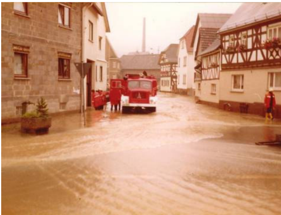
Bild 22: Blick in die Bornbachstraße beim Hochwasser 1981
